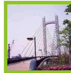
木場公園大橋
