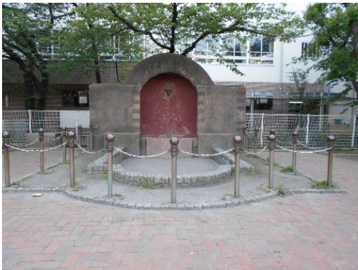
元加賀公園 壁泉付路床
