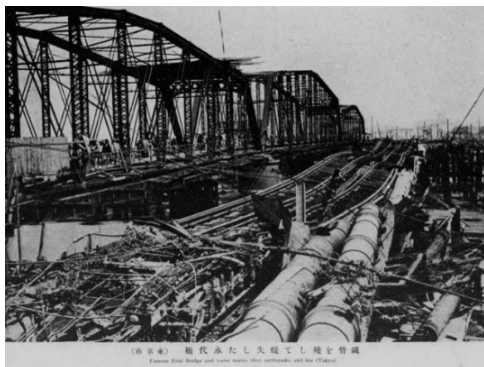
鉄骨を残して焼失した永代橋
