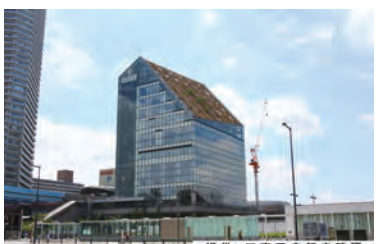
周辺はまだ工事中だった頃の豊洲シビックセンター
