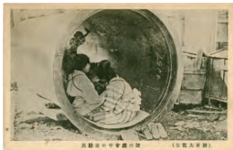
関東大震災 深川鉄管中の避難民 (江東区教育委員会蔵)
